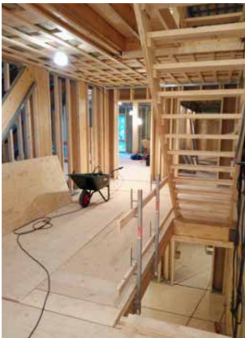
Eken 2 byggs med limträkonstruktion, tillsammans med byggentreprenören Stenmarks bygg och Moelven, som levererar konstruktionen.
