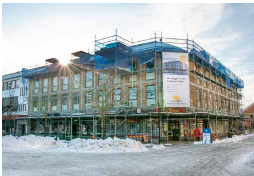
30 nya hem mitt i centrum byggs under 2018.
